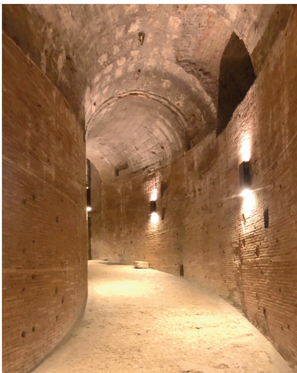
Fig. 6.36 - Il primo tratto della Rampa elicoidale con la volta in opera cementizia (foto Autrice).
